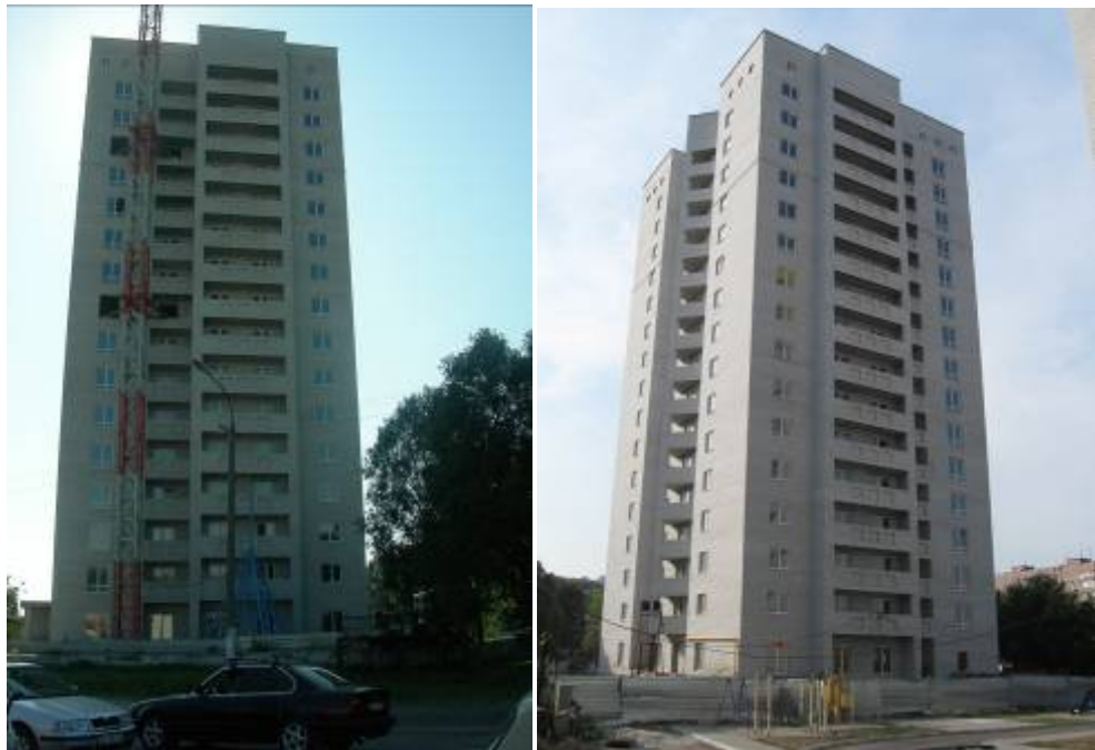
Ступінь будівельної готовності об'єкта в районі вулиць Космічної та Мандриківської, м. Дніпропетровськ (друга черги) станом: (зліва-направо): на кінець травня 2009 року та на вересень 2009 року
