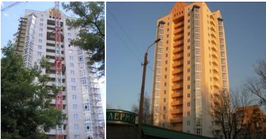
Об'єкт по проспекту газети «Правда» в районі будинку №16, м. Дніпропетровськ станом на 23.06.2008 р. та станом на кінець листопада 2008 року
