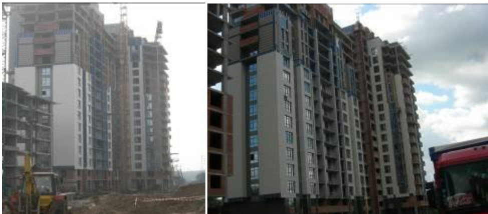
Рисунок 1.3. Хід робіт з будівництва ж/б 3 по вул. Професора Підвисоцького у Печерському районі м. Києва станом (зліва-направо): на 12.03.2009 р. та на 18.06.2009 р.
