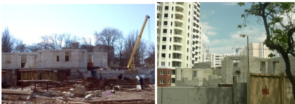
Рисунок 3. Стан будівництва по вул. Хантадзе, 7 В у м. Іллічівську станом на березень та червень 2010 року
