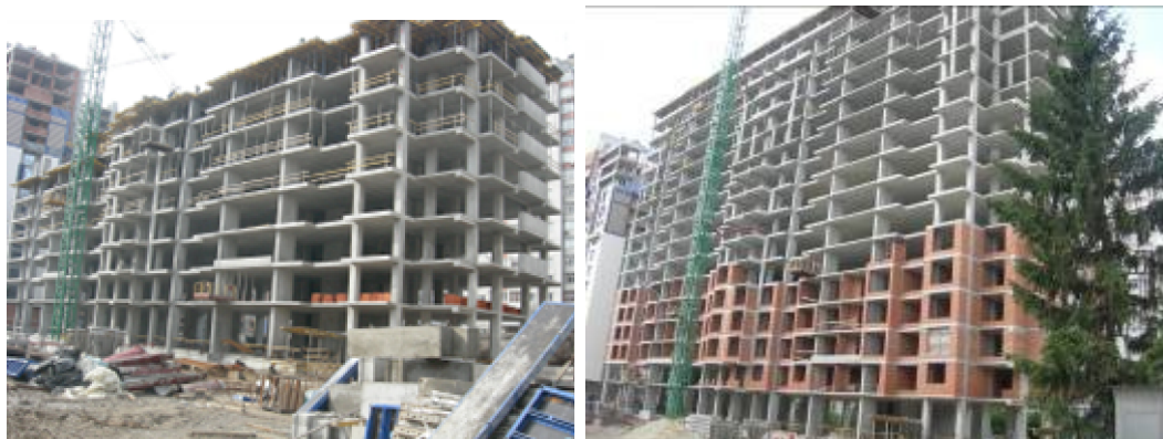
Рисунок 1.4. Хід робіт з будівництва ж/б 4 по вул. Професора Підвисоцького у Печерському районі м. Києва станом (зліва-направо): на 12.03.2009 р. та на 18.06.2009 р.
