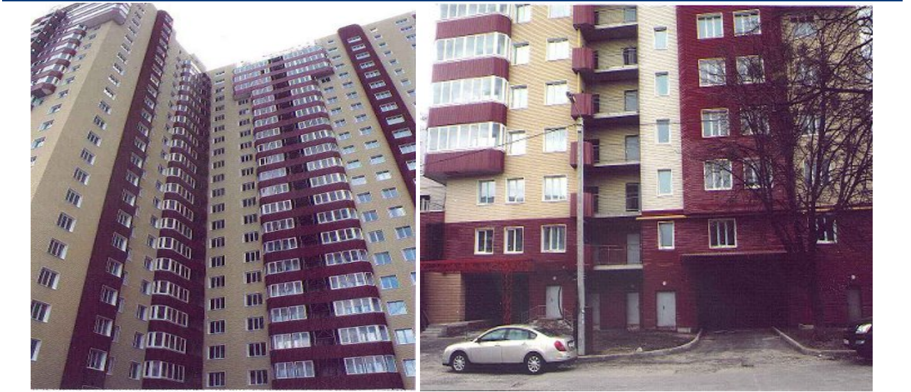
Об'єкт будівництва по вул. 23 Серпня (в районі буд. 31) у м. Харкові станом на кінець березня 2011 року
