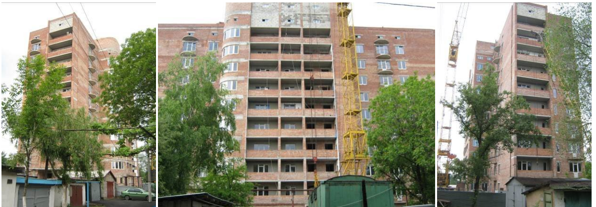
Стан будівництва житлового будинку по вул. Бакинських Комісарів, 100 у м. Донецьку станом на 29.05.2009 р.
