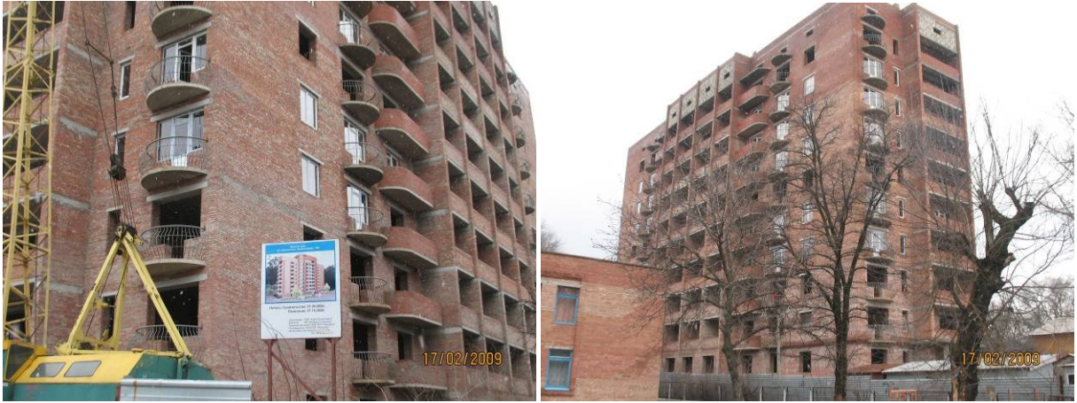
Стан будівництва житлового будинку по вул. Бакинських Комісарів, 100 у м. Донецьку станом на 17.02.2009 р.
