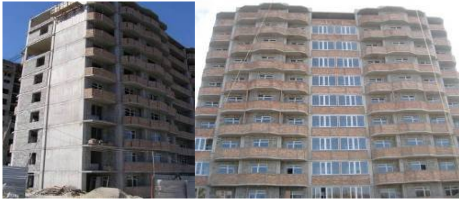
Стан будівництва 2-х житлових будинків по вул. Рєпіна, 19 у м. Севастополі станом на 05.09.2008 р. та станом на 25.10.2008 р.
