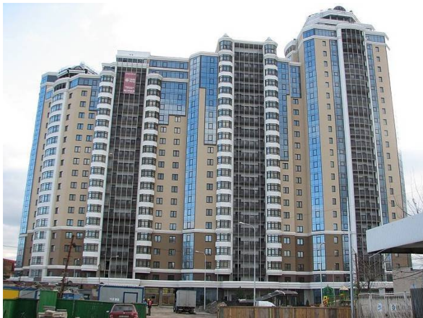
Перша черга житлового комплексу «Космополітен» по вул. Дегтярівській, 25а у м. Києві
