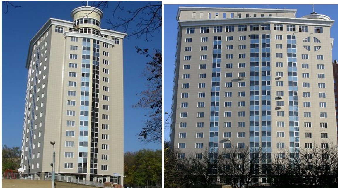
Об'єкт будівництва по пр. Панфілова
