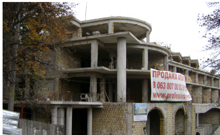
Стан будівництва рекреаційного комплексу по вул. Дворцове шосе, 3 у м. Алупці станом на початок 2009 р.
