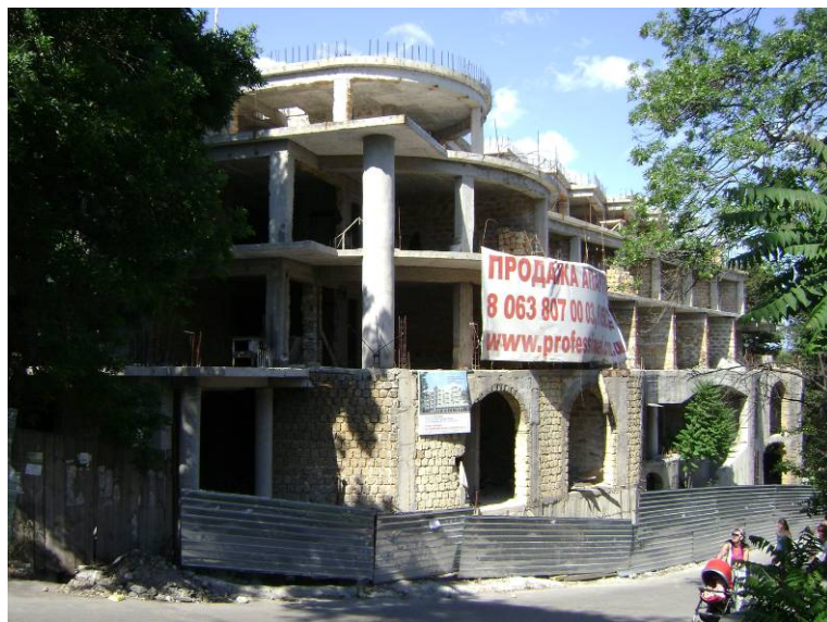
Стан будівництва рекреаційного комплексу по вул. Дворцове шосе, 3 у м. Алупці станом на 04.06.2009 р.
