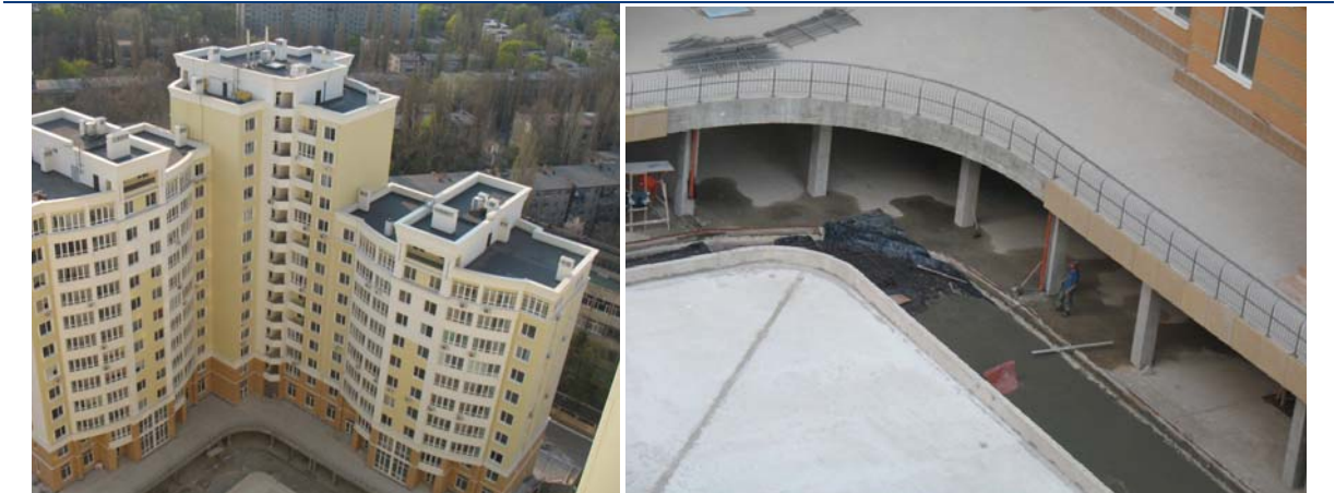
Житловий комплекс по вул. Армійській, 11 в м. Одеса
