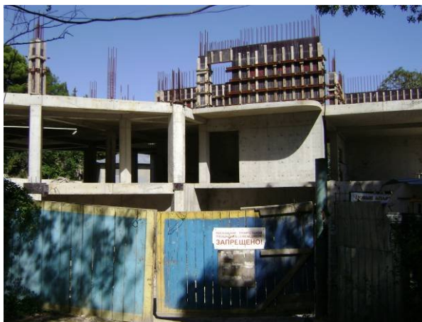
Хід будівництва рекреаційного комплексу по вул. Луговського в смт. Сімеїз станом на 21.08.2009 р.
