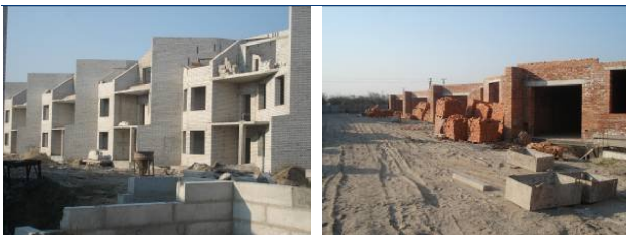
Рисунок Ошибка! Текст указанного стиля в документе отсутствует..4. Хід будівництва житлового комплексу з об'єктами соціально-побутової інфраструктури по вул. Леніна, 119 у с. Петропавлівська Борщагівка Києво-Святошинського району Київської області станом на кінець квітня 2009 року
