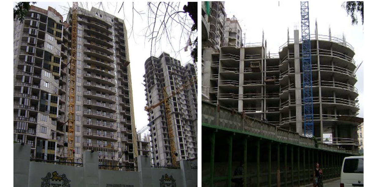
Будівництво житлово-офісного комплексу з вбудованими, прибудованими приміщеннями та підземним паркінгом по вул. Анрі Барбюса, 37/1 у Печерському районі м. Києва станом на 24.06.2010 р.
