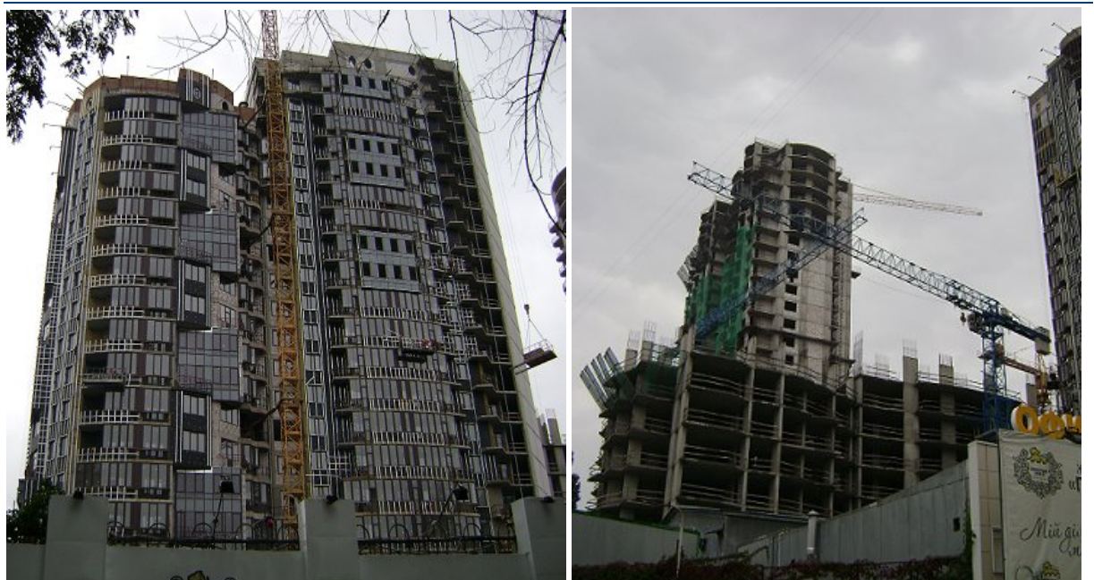
Будівництво житлово-офісного комплексу з вбудованими, прибудованими приміщеннями та підземним паркінгом по вул. Анрі Барбюса, 37/1 у Печерському районі м. Києва станом на 20.09.2010 р.
