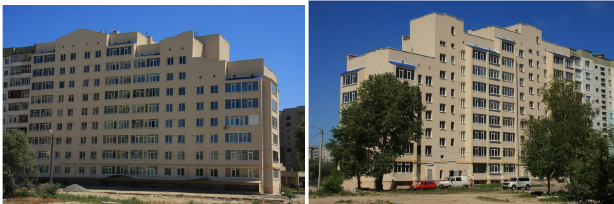
Рисунок 2. Будівництво житлового будинку з офісними приміщеннями по вул. Черепіна, 42-в у м. Сумах станом на червень 2010 року
