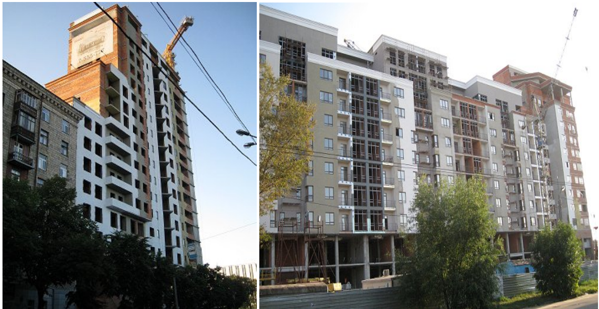
Хід робіт на об'єкті будівництва по пров. Банному в м. Харкові станом на 21.08.2009 р.
