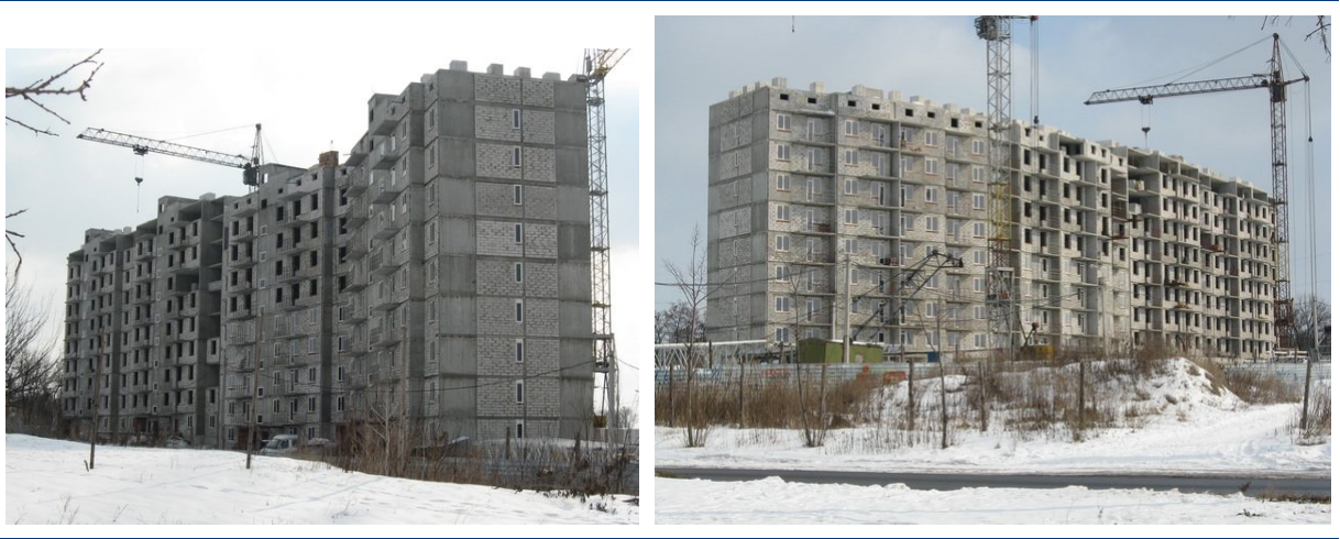
Хід будівництва житлового будинку по вул. Зубарева, 7 у м. Харкові станом на кінець березня 2012 р.
