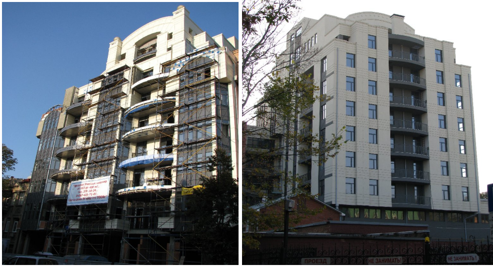
Будівництва 10-поверхового житлового будинку у м. Дніпропетровську по вул. Комсомольській, 12-А
