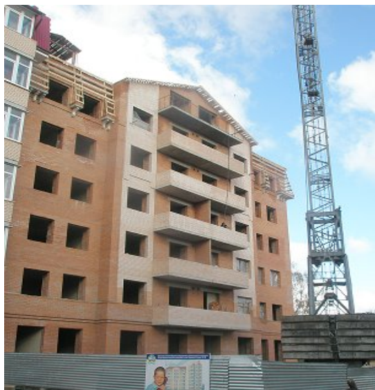
Житловий будинок по вул. Паризької комуні, 20 у м. Полтаві, станом на 02.11.2009 року
