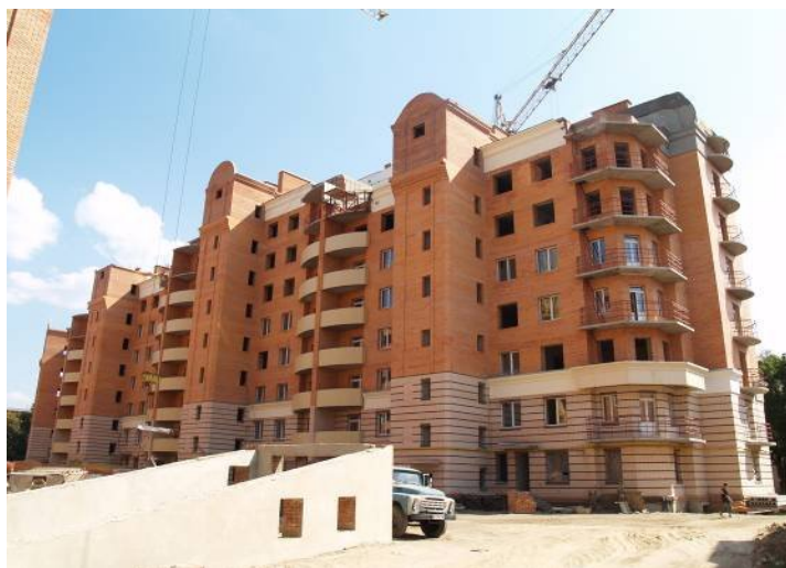
Житловий будинок по вул. Жовтневій, 40-В у м. Полтаві, станом на середину червня 2009 року
