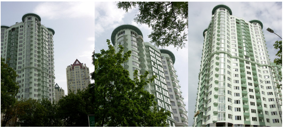
Рисунок 2. Будівельні роботи на об'єкті будівництва житлового комплексу по вул. Механізаторів, 2 (ж/к «Ізумрудний») у Солом'янському районі м. Києва станом на серпень 2010 р.
