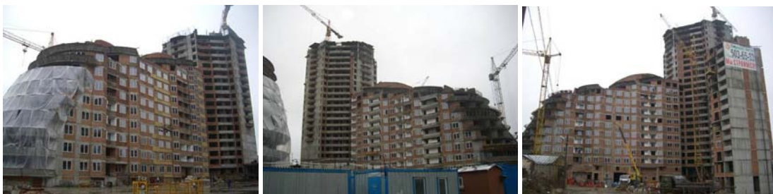
Ступінь виконання будівельних робіт житлового комплексу «Крістова гірка» (I черга) по вул. Вишгородській, 45 у м. Києві (зверху зліва-направо секції 4.2, 3.3, 1.3 та секції 2.2, 1.3; знизу зліва-направо секції 4.1, 3.2, 1.2, 2.1 та загальний вигляд будівництва) станом на 20.02.2009 р.
