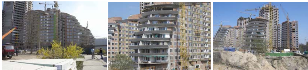
Ступінь виконання будівельних робіт житлового комплексу «Крістова гірка» (I черга) по вул. Вишгородській, 45 у м. Києві (зверху зліва-направо секції 4.2, 3.3, 1.3, 2.2, 1.3 та секції 4.1, 3.2, 1.2, 2.1, знизу зліва-направо загальний вигляд будівництва I черги) станом на початок травня 2009 року
