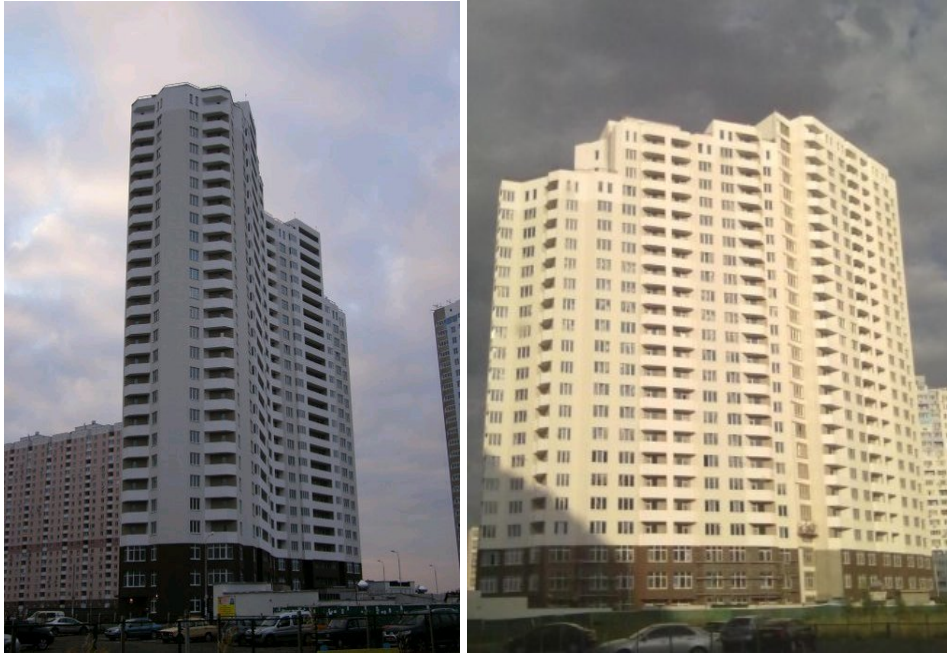
Об'єкт будівництва житлового будинку по вул. О. Пчілки у 4-му м/н ж/м Позняки
