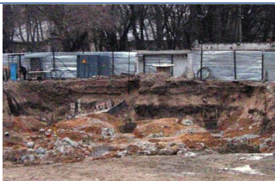
Рисунок 2.3. Хід робіт на об'єкті будівництва по вул. Станіславського, 3 у м. Дніпропетровську станом на 14.02.2008 р.
