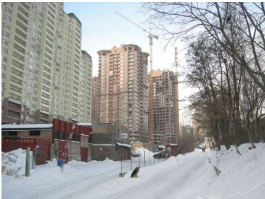
Рисунок 2. Будівельні роботи на об'єкті будівництва житлового комплексу по вул. Механізаторів, 2 (ж/к «Ізмурдний») у Солом'янському районі м. Києва станом на березень 2010 р.
