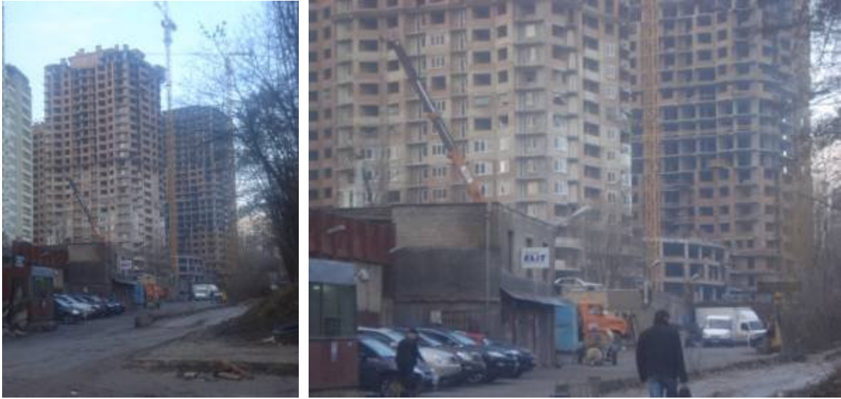
Рисунок 1. Будівельні роботи на об'єкті будівництва житлового комплексу по вул. Механізаторів, 2 (ж/к «Ізмурдний») у Солом'янському районі м. Києва станом на 21.11.2009 р.
