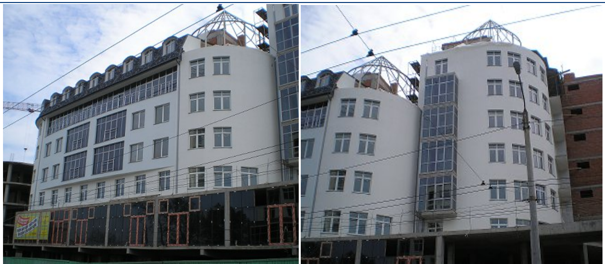
Хід будівництва групи багатоквартирних житлових будинків по вул. Червоноармійській, 43 В у м. Чернівцях станом на початок травня 2010 року
