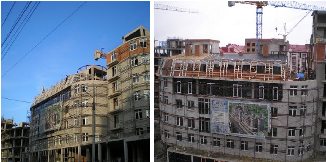
Хід будівництва групи багатоквартирних житлових будинків по вул. Червоноармійській, 43 В у м. Чернівцях станом на 16.02.2010 р.
