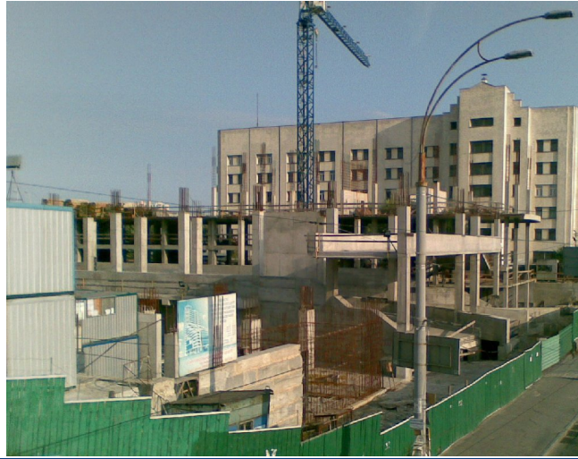
Стан будівництва офісної будівлі за адресою: м. Київ, пров. Індустріальний, 1-А
