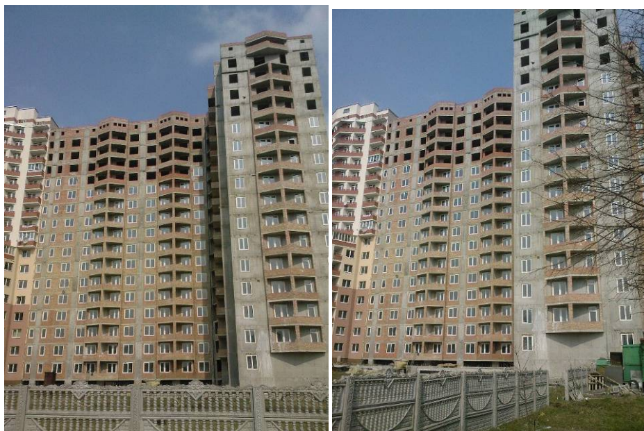
Хід будівництва багатопверхового житлового будинку з вбудованими офісними приміщеннями та підземними автостоянками по вул. Панча, 18-б у м. Львові станом на квітень 2009 року
