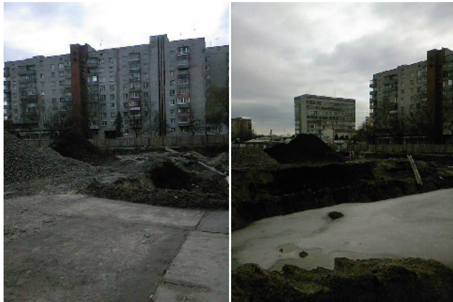
Хід будівництва багатоповерхового житлового будинку з вбудованими офісними приміщеннями та підземними автостоянками на пр. В. Чорновола – вул. П. Панча в м. Львові станом на середину лютого 2009 року
