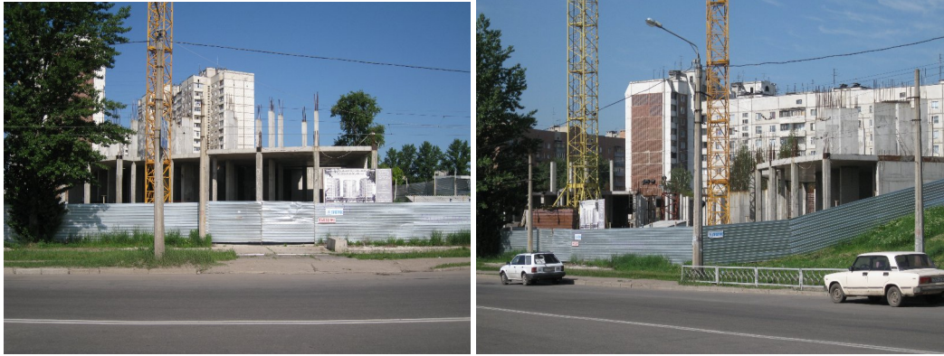
Будівництво ж/б з вбудовано-прибудованими приміщеннями культурно-побутового, адміністративного призначення та торговельного центру, з підземним паркінгом та гостьовою автостоянкою по вул. Шевченка (район вул. Саперної) у м. Харкові станом на кінець серпня 2009 року
