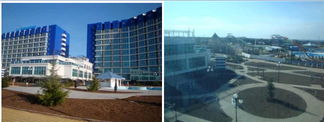
Рисунок 2. Хід робіт на об'єкті будівництва у парку Перемоги в м. Севастополі станом на лютий 2011 року
