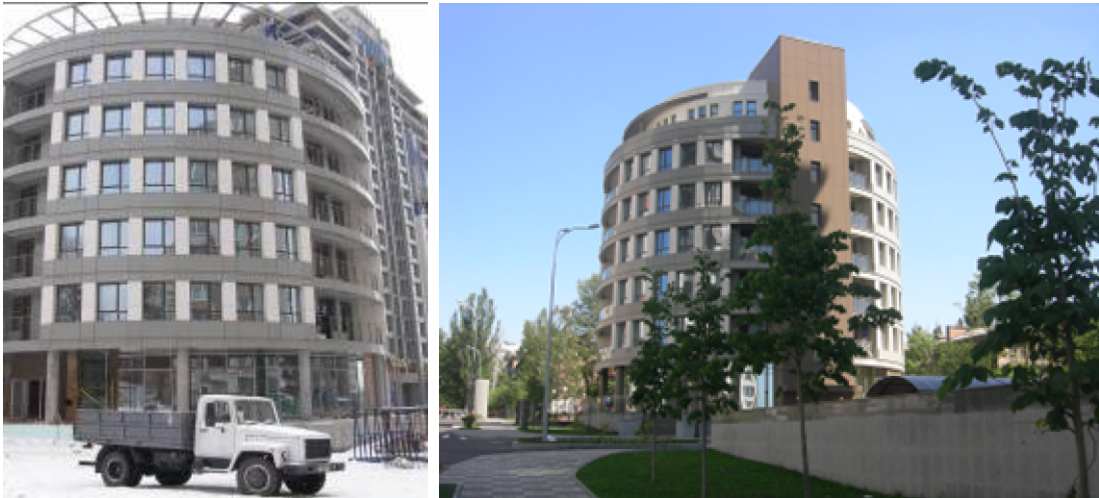
Хід робіт з будівництва ж/б 1 по вул. Професора Підвисоцького у Печерському районі м. Києва станом (зліва-направо): на 18.03.2010 р. та на 08.06.2010 р.
