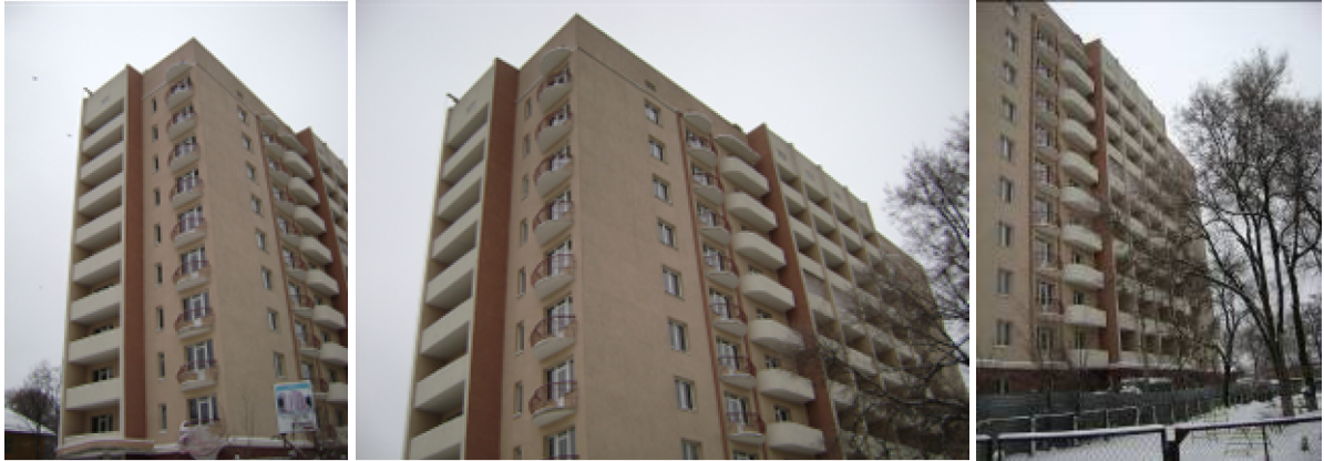
Хід робіт на об'єкті будівництва житлового будинку по вул. Бакинських Комісарів, 100 у м. Донецьку станом на грудень 2010 року Джерело: ТОВ «Кредит-Рейтинг»
