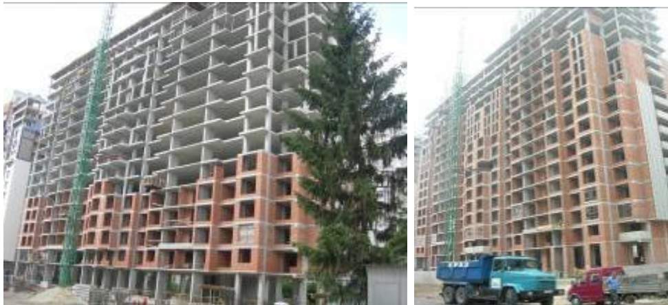
Хід робіт з будівництва ж/б 4 по вул. Професора Підвисоцького у Печерському районі м. Києва станом (зліва-направо): на 18.06.2009 р. та на 03.09.2009 р.
