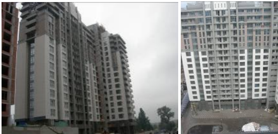
Хід робіт з будівництва ж/б 3 по вул. Професора Підвисоцького у Печерському районі м. Києва станом (зліва-направо): на 03.09.2009 р. та на 19.11.2009 р.
