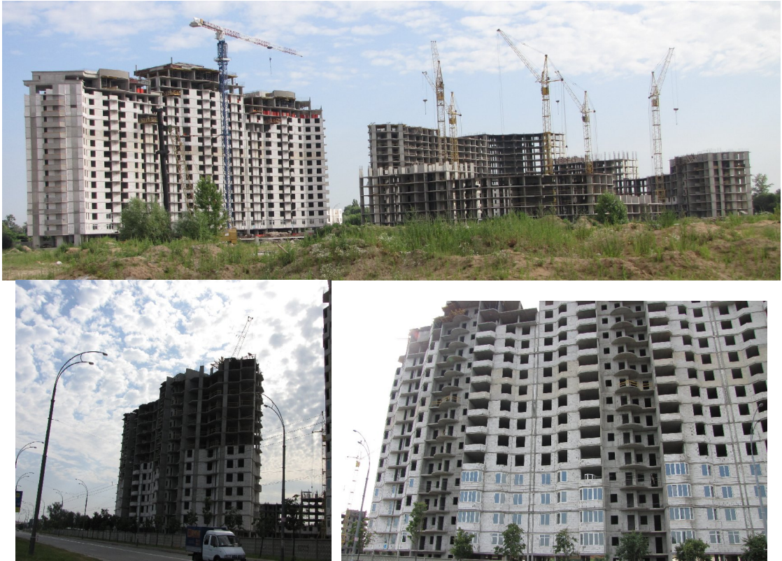
Рисунок 3.2. Стан будівництва житлових будинків з підземними паркінгами та закладів з обслуговування населення по вул. Вільямса,7 та вул. Ломоносова, 42-50 (III мікрорайон) у м. Києві на 30.06.2009 р.
