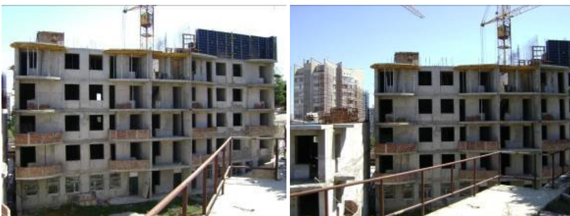
Стан будівництва житлового комплексу, який складається з житлових будинків (блок «Б1», блок «Б2», блок «Г») та підземних автостоянок (блок «А», блок «В») по вул. Жовтневій в районі житлового будинку №32 у м. Алушті станом на 21.08.2009 р.
