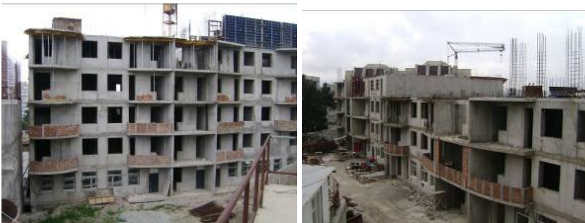
Стан будівництва житлового комплексу, який складається з житлових будинків (блок «Б1», блок «Б2», блок «Г») та підземних автостоянок (блок «А», блок «В») по вул. Жовтневій в районі житлового будинку №32 у м. Алушті станом на 04.06.2009 р.
