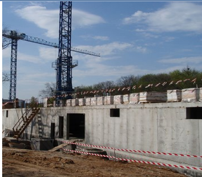
Стан будівництва житлового комплексу по вул. Фронтівій, 3 у м. Харкові станом на кінець 2009 року
