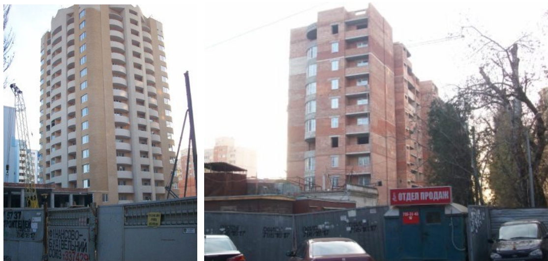
Рисунок 4. Стан будівництва громадсько-житлового комплексу по вул. М. Говорова, 10 А у м. Одесі на початок 2010 р.
