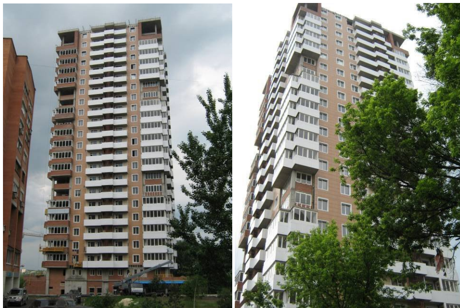
Будівництво житлового будинку №1 по пр. Панфілова у м. Донецьку станом на 29.05.2009 р.
