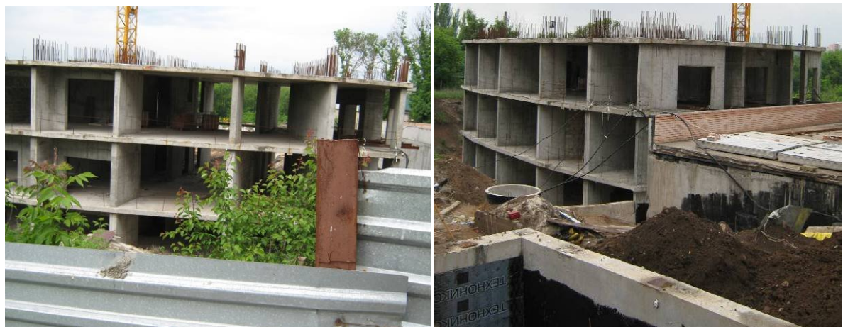
Будівництво житлового будинку №2 по пр. Панфілова у м. Донецьку станом на 29.05.2009 р.
