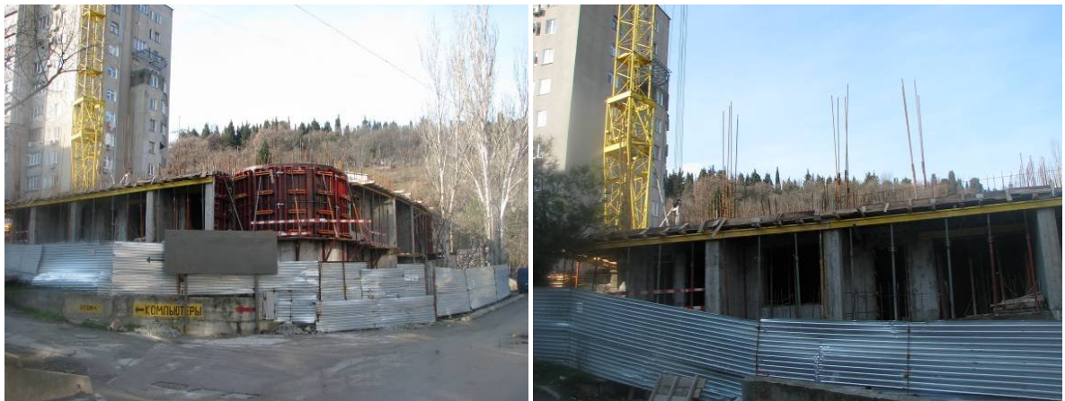
Будівельні роботи по вул. Грибоєдова в районі будинку №13 у м. Ялті станом на 31.12.2008 р.
