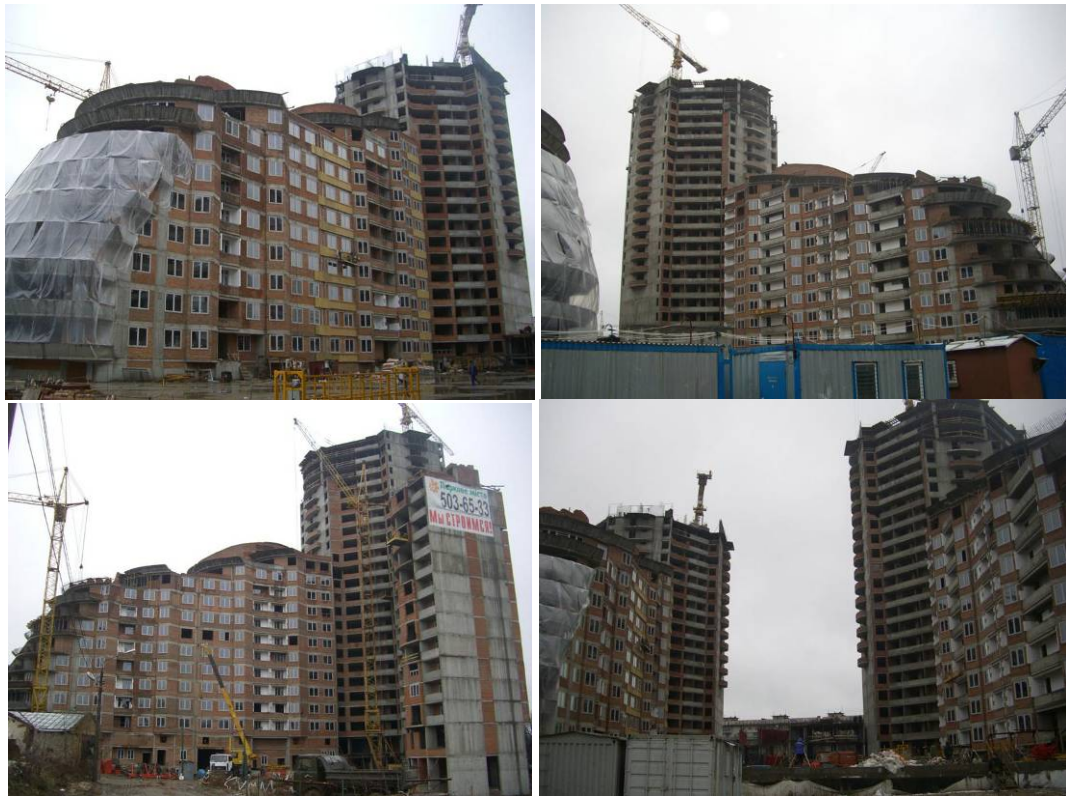
Рисунок 1.2. Ступінь виконання будівельних робіт житлового комплексу «Крістова гірка» (I черга) по вул. Вишгородській, 45 у м. Києві (зверху зліва-направо секції 4.2, 3.3, 1.3 та секції 2.2, 1.3; знизу зліва-направо секції 4.1, 3.2, 1.2, 2.1 та загальний вигляд будівництва) станом на 20.02.2009 р.
