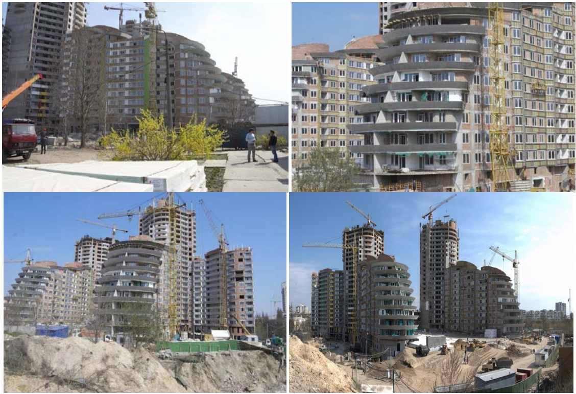
Рисунок 1.3. Ступінь виконання будівельних робіт житлового комплексу «Крістова гірка» (I черга) по вул. Вишгородській, 45 у м. Києві (зверху зліва-направо секції 4.2, 3.3, 1.3, 2.2, 1.3 та секції 4.1, 3.2, 1.2, 2.1, знизу зліва-направо загальний вигляд будівництва I черги) станом на початок травня 2009 року
