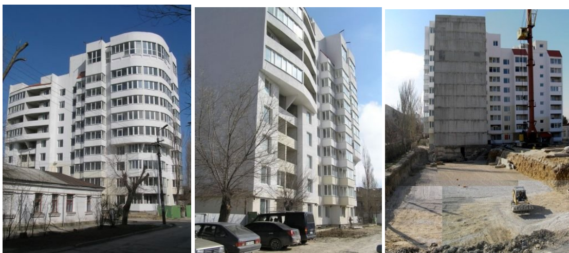
Рисунок 1. Будівельні роботи по вул. Вересаєва, 12 у м. Феодосії станом на лютий 2010 року
