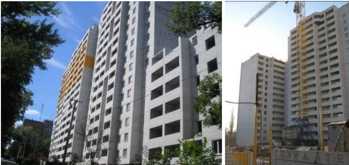
Об'єкт по вул. Дмитра Кедріна, в районі будинку №55, м. Дніпропетровськ станом на 23.06.2008 р. та станом на кінець лютого 2009 року
