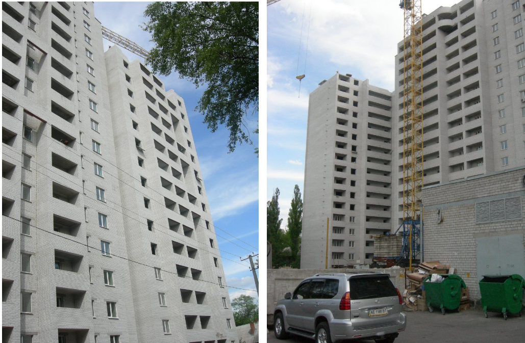
Об'єкт по вул. Дмитра Кедріна, в районі будинку №55, м. Дніпропетровськ станом на кінець травня 2009 року
