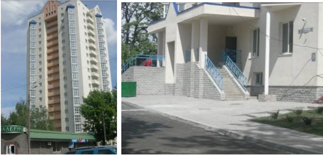
Об'єкт по проспекту газети «Правда» в районі будинку №16, м. Дніпропетровськ станом на кінець травня 2009 року
