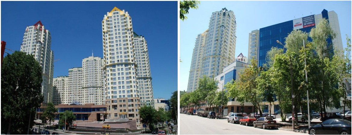
Рисунок 1.1. Житловий комплекс по вул. Механізаторів, 2 (ж/к «Времена года») у Солом'янському районі м. Києва
