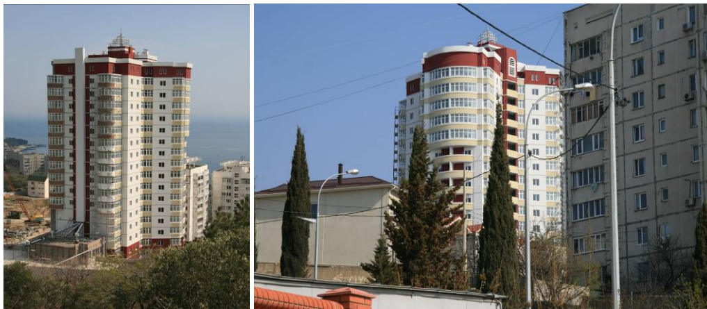
Рисунок Ошибка! Текст указанного стиля в документе отсутствует..2. Стан робіт на об'єкті будівництва по вул. Южній, 64-66 (II черга), станом на 05.05.2009 р.
