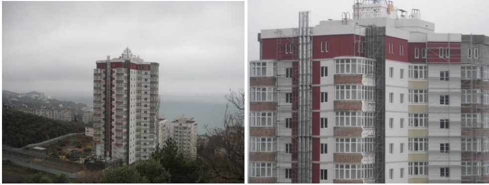
Рисунок Ошибка! Текст указанного стиля в документе отсутствует..1. Стан робіт на об'єкті будівництва по вул. Южній, 64-66 (I черга), станом на 02.03.2009 р.
