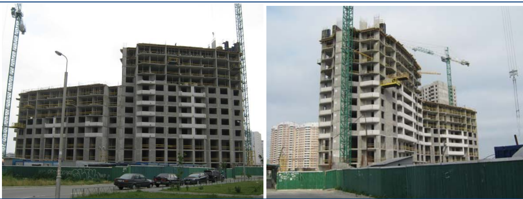
Рисунок 1.2. Стан будівництва житлового будинку по вул. О. Пчілки у 4-му м/н ж/м Позняки на кінець червня 2009 року
