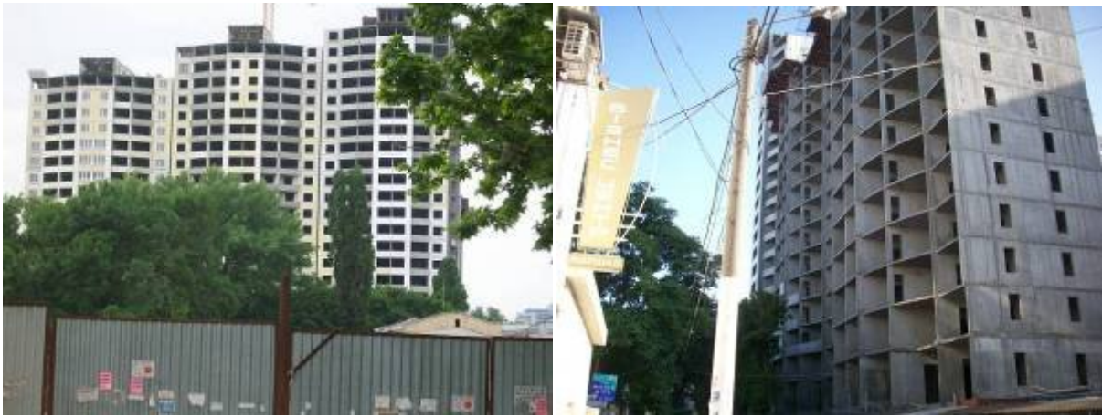
Будівництво житлового комплексу вул. Арміській, 11 станом на 29.05.2009 р. та станом на 08.09.2009 р.
