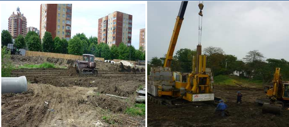
Хід будівництва 9-ти поверхового багатоквартирного житлового будинку з вбудованими приміщеннями громадського призначення по вул. А. Манастирського у м. Львові станом на початок червня 2012 року та кінець вересня 2012 року (зліва направо)
