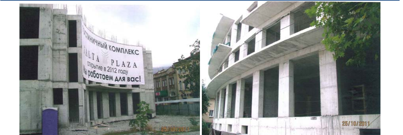
Хід робіт на об'єкті будівництва по вул. Ігнатенко, 9 у м. Ялті станом на 25.10.2011 р.
