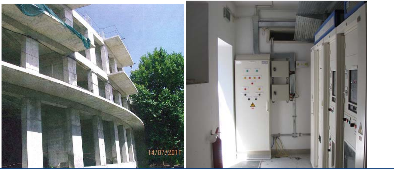
Хід робіт на об'єкті будівництва по вул. Ігнатенко, 9 у м. Ялті станом на 14.07.2011 р.
