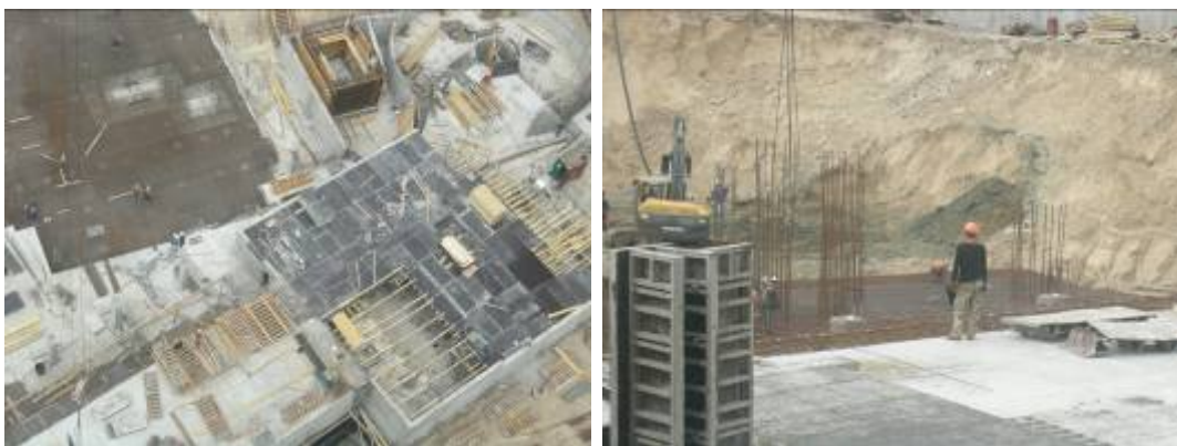
Рисунок 1.5. Хід будівництва житлового комплексу «Парк Авеню» (II- IV черги) станом на 20.05.2009 р.
