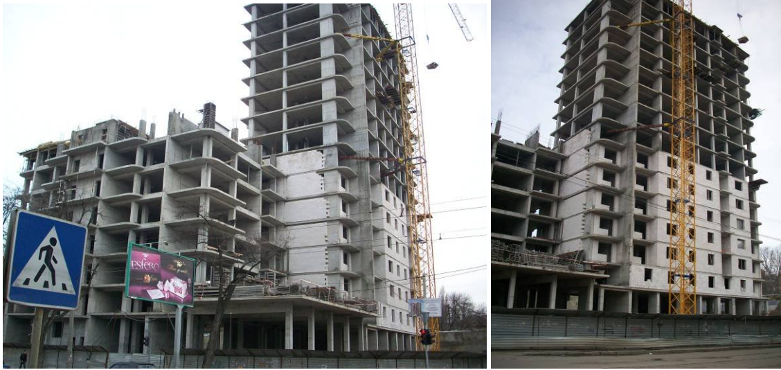
Стан будівництва житлового будинку по вул. Прохорівській, 39-41 у м. Одесі, на 01.01.2009 р.
