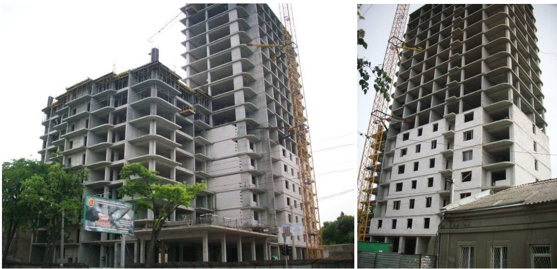
Стан будівництва житлового будинку по вул. Прохорівській, 39-41 у м. Одесі, на 29.05.2009 р.
